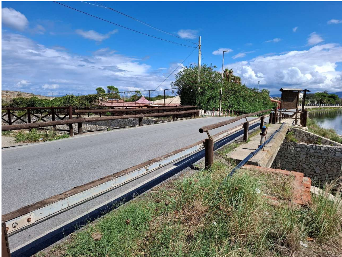
8- VISTA DELLA STRADA SOPRASTANTE IL PONTE
