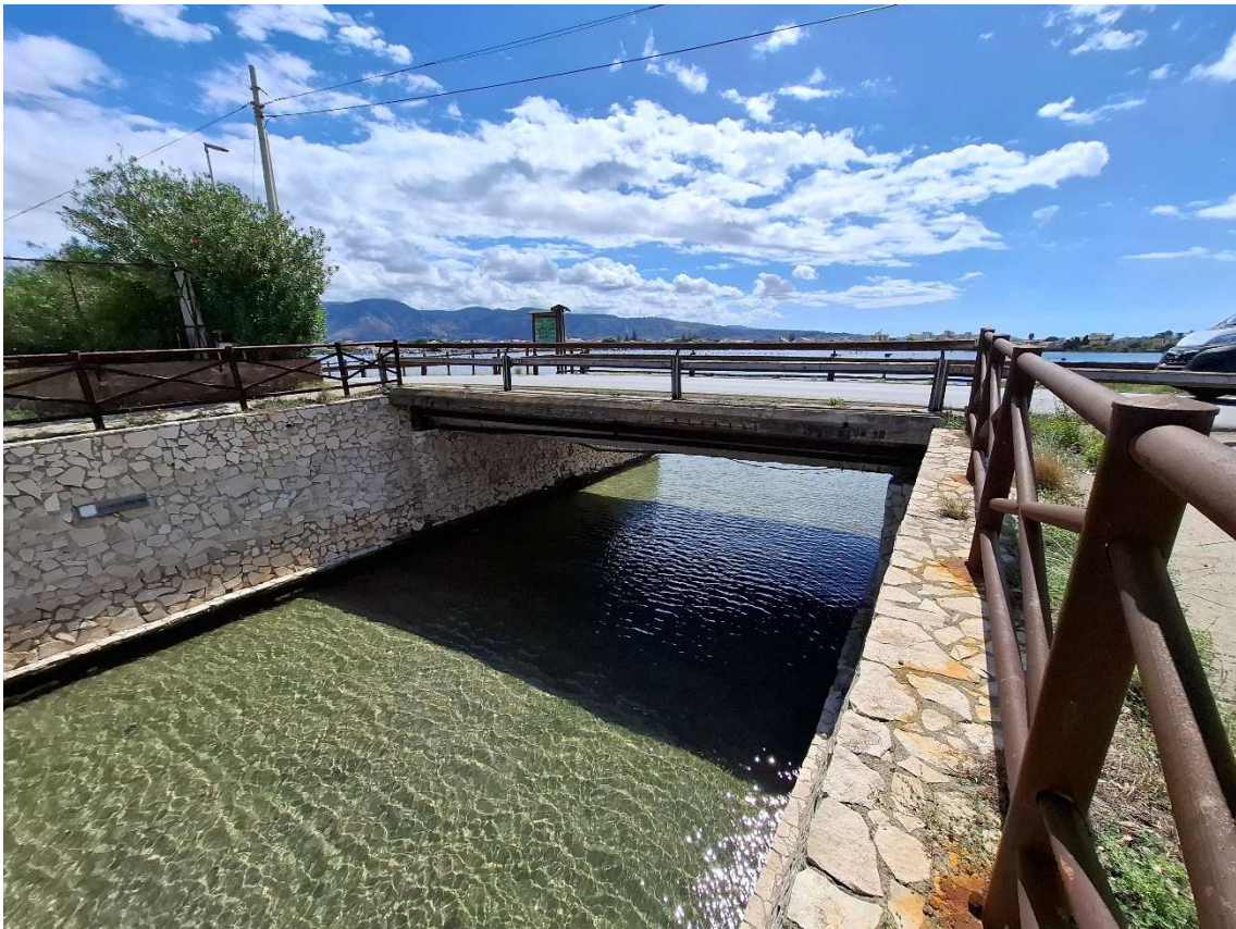
2- VISTA DEL PONTE DAL CANALE
