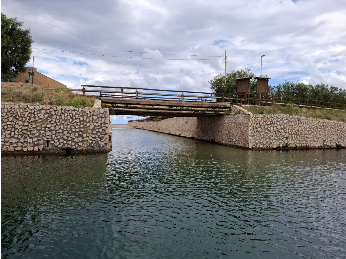
1 – VISTA DEL PONTE DAL LAGO FARO
