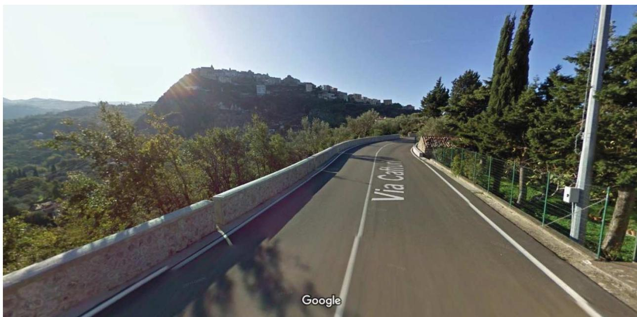
**Foto N° 5: Stato di fatto –precedente intervento al Km. 4+970 costruzione parapetto con paramento in pietrame, alla cui tipologia si fa riferimento nel presente progetto**
