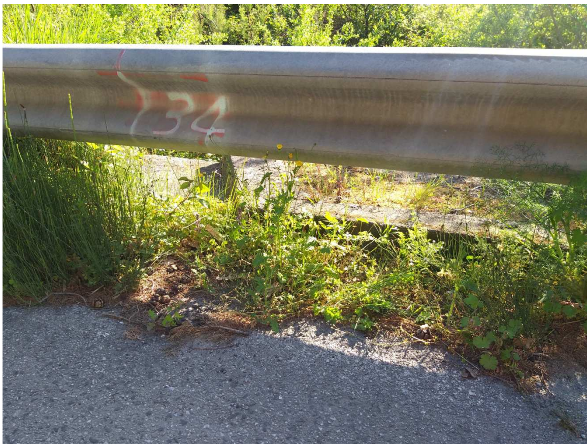
Foto N° 4: Particolare della quota del muro d'argine rispetto alla carreggiata stradale.
