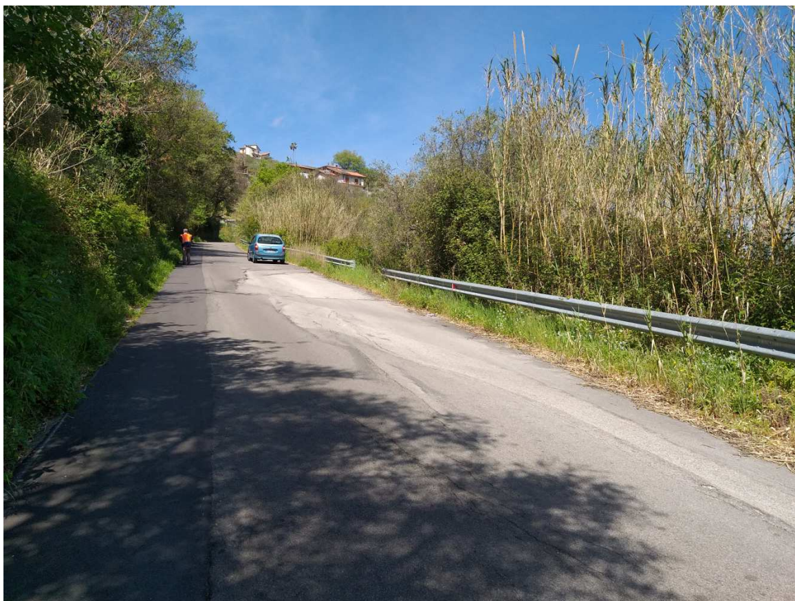
Foto N° 8: Tratto di carreggiata stradale da sistemare con terre rinforzate sulla S. P. 145 Sinagra – Limari.
