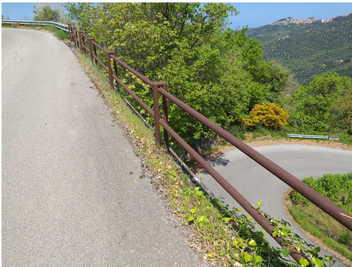
Foto N° 10: Tratto di ringhiera, da uniformare con H2 tripla onda su manufatto.
