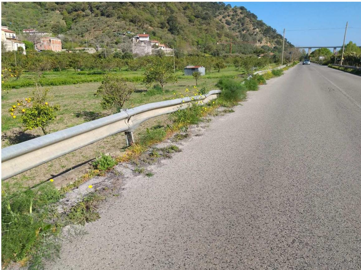
Foto N° 3: Altro tratto di barriera metallica di sicurezza danneggiata, da sostituire - Km. 1+700 circa.
