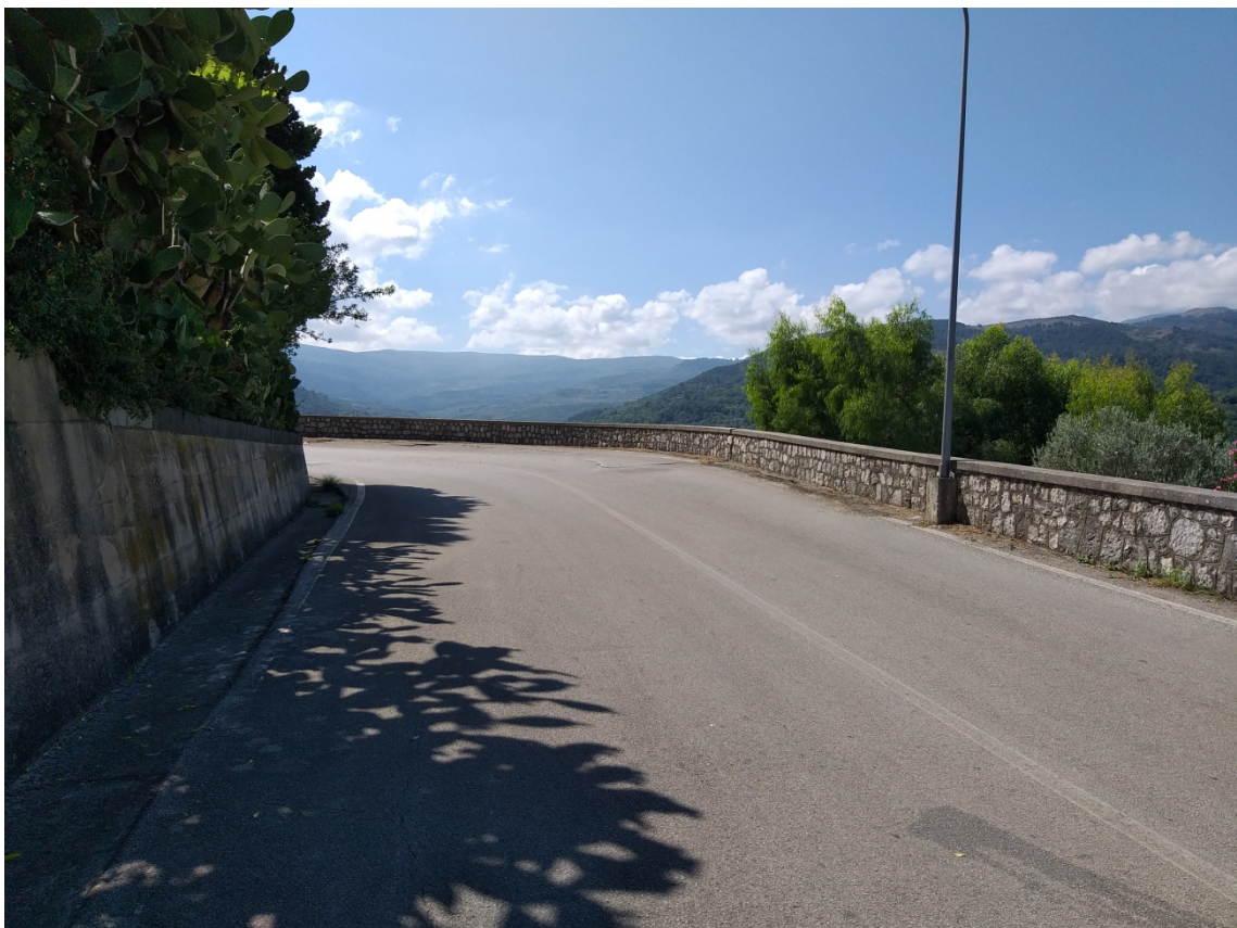
Figura 7: Situazione dei luoghi al Km. 14+700 circa - Intervento N° 2
