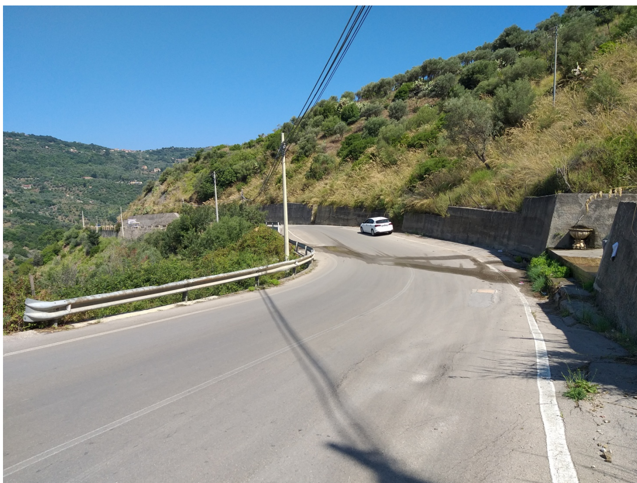
Figura 1: Situazione dei luoghi al Km. 14+200 circa - Intervento N° 1
