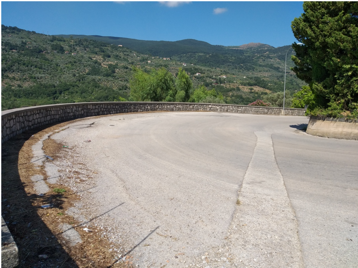
Figura 6: Situazione dei luoghi al Km. 14+700 circa - Intervento N° 2
