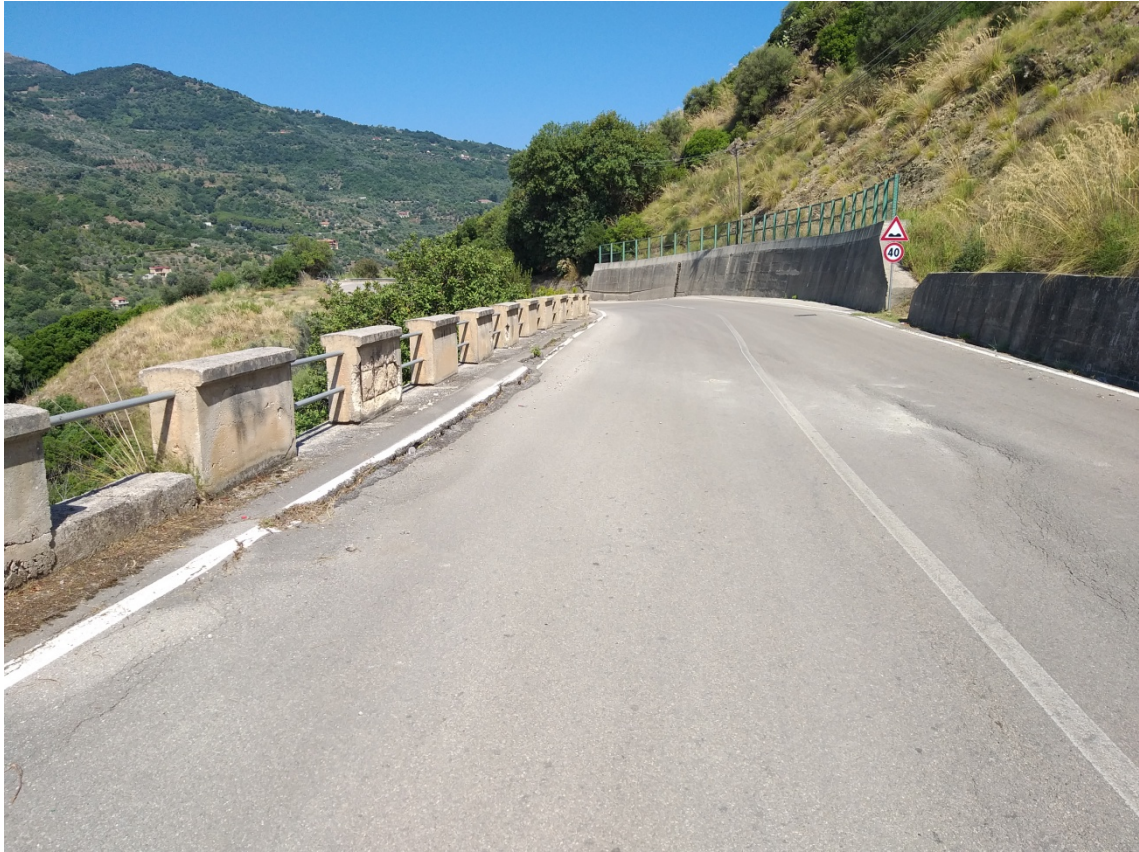
Figura 4: Situazione dei luoghi al Km. 14+200 circa - Intervento N° 1
