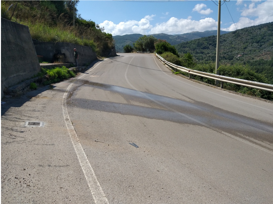
Figura 2: Situazione dei luoghi al Km. 14+200 circa - Intervento N° 1
