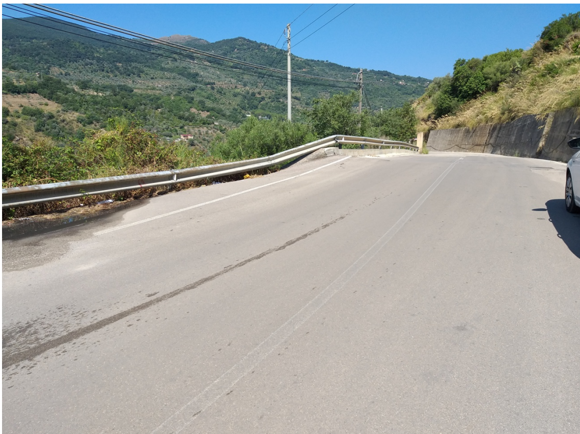
Figura 3: Situazione dei luoghi al Km. 14+200 circa - Intervento N° 1
