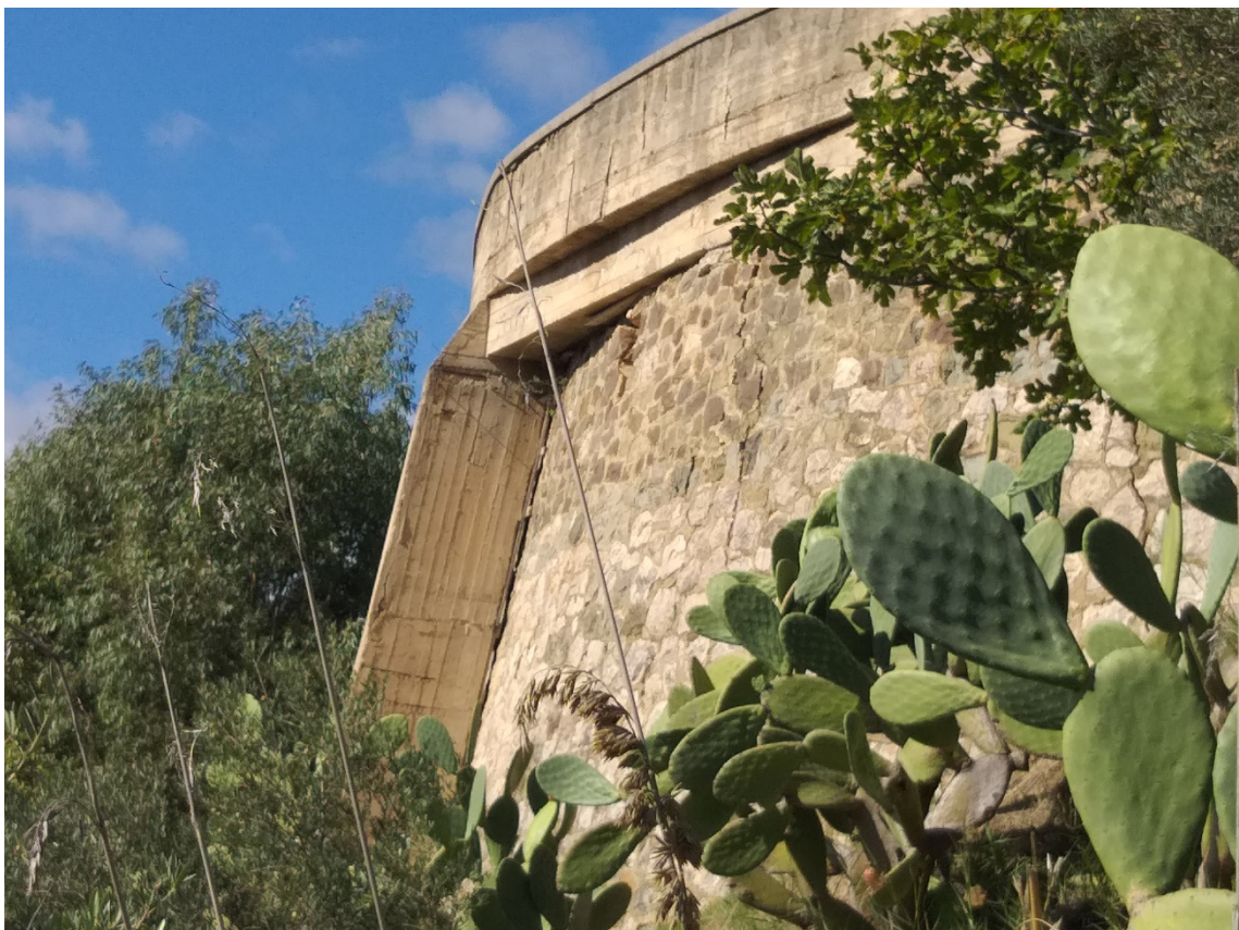
Figura 9: Situazione dei luoghi al Km. 14+700 circa, muro di sostegno della carreggiata - Intervento N° 2
