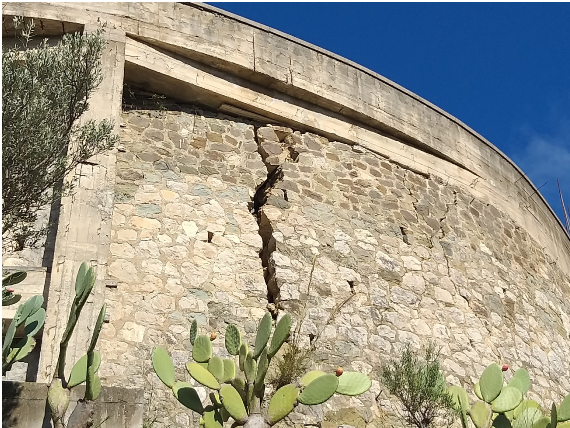
Figura 8: Situazione dei luoghi al Km. 14+700 circa, muro di sostegno della carreggiata - Intervento N° 2
