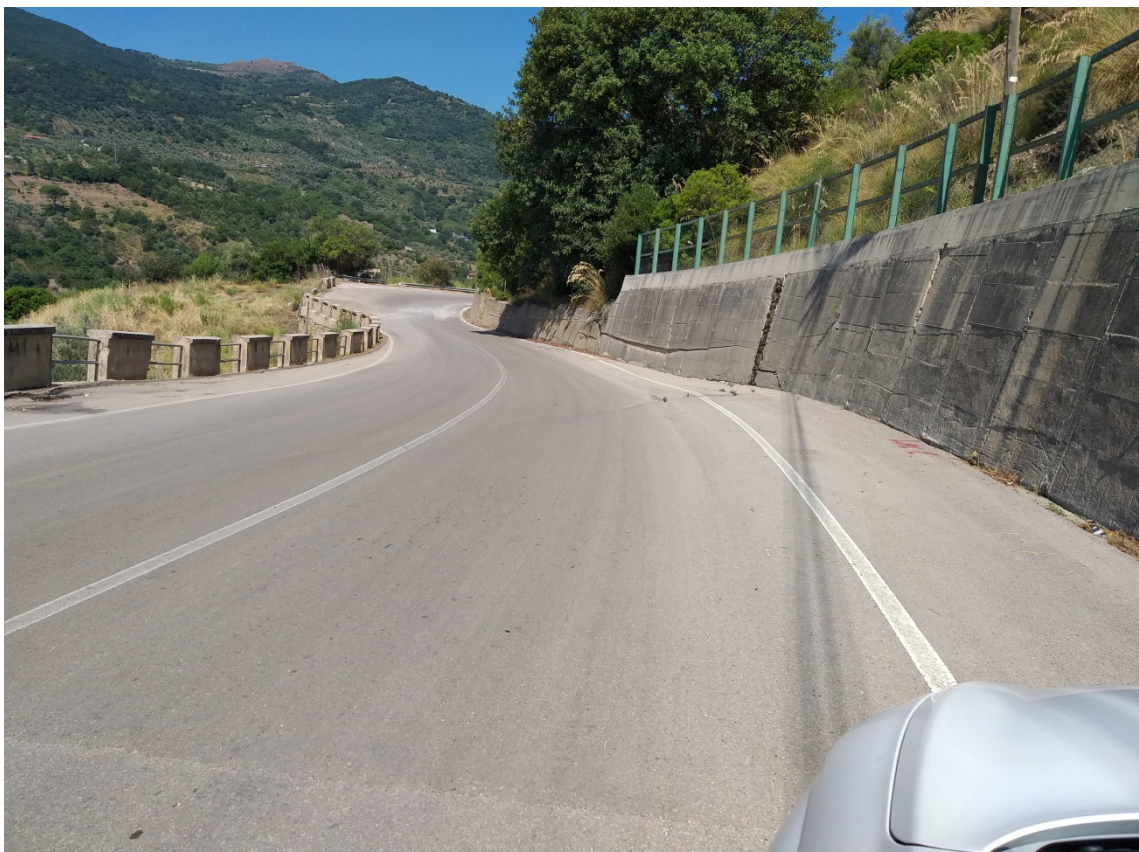
Figura 5: Situazione dei luoghi al Km. 14+200 circa - Intervento N° 1
