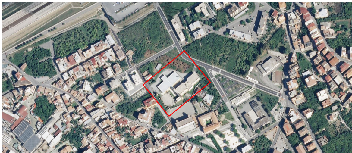
Figura 1 – Foto aerea con localizzazione dell'edificio scolastico
