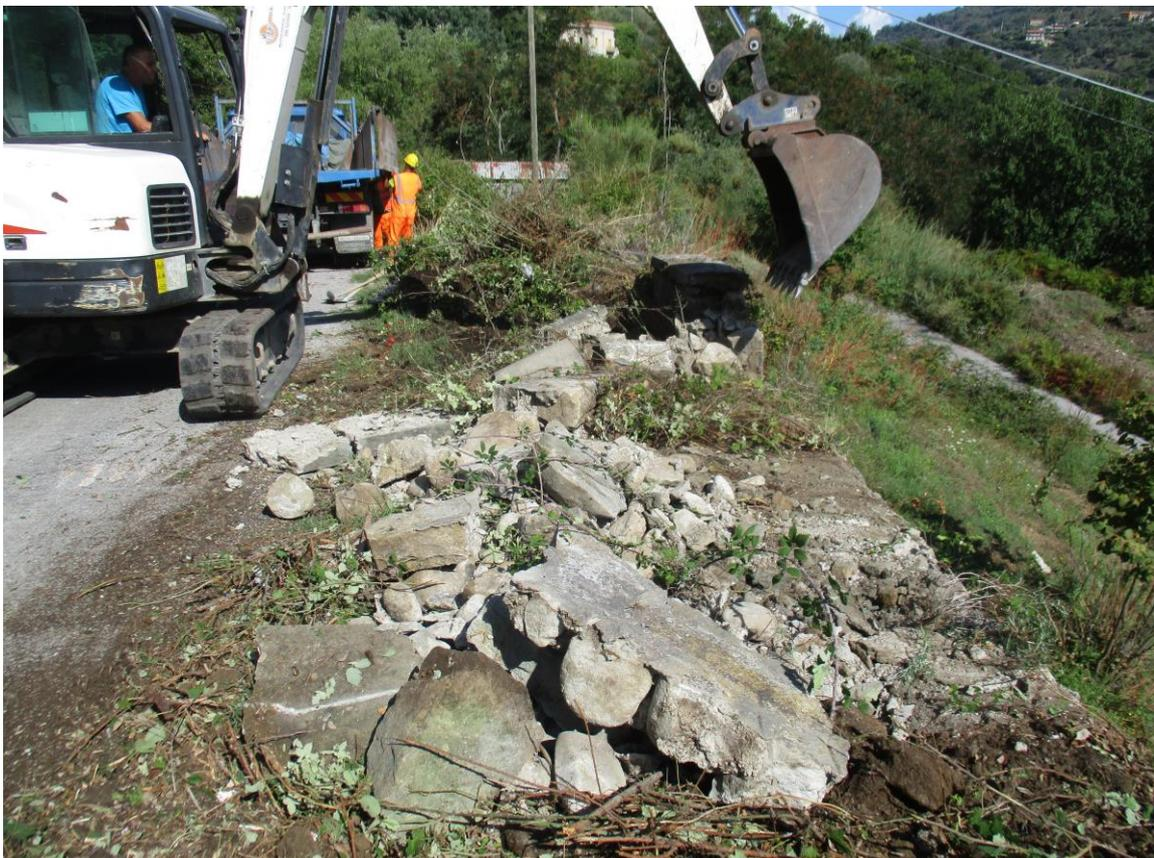
S.P. 145 – Pulitura e demolizione parapetto esistente per realizzazione cunetta
