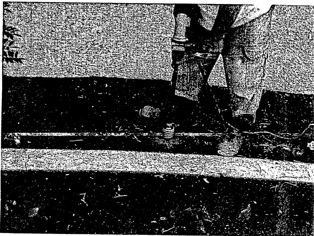
Foto n. 2 Saggio per rilievo spessore conglomerato bituminoso SP 52Bis km0+300.
