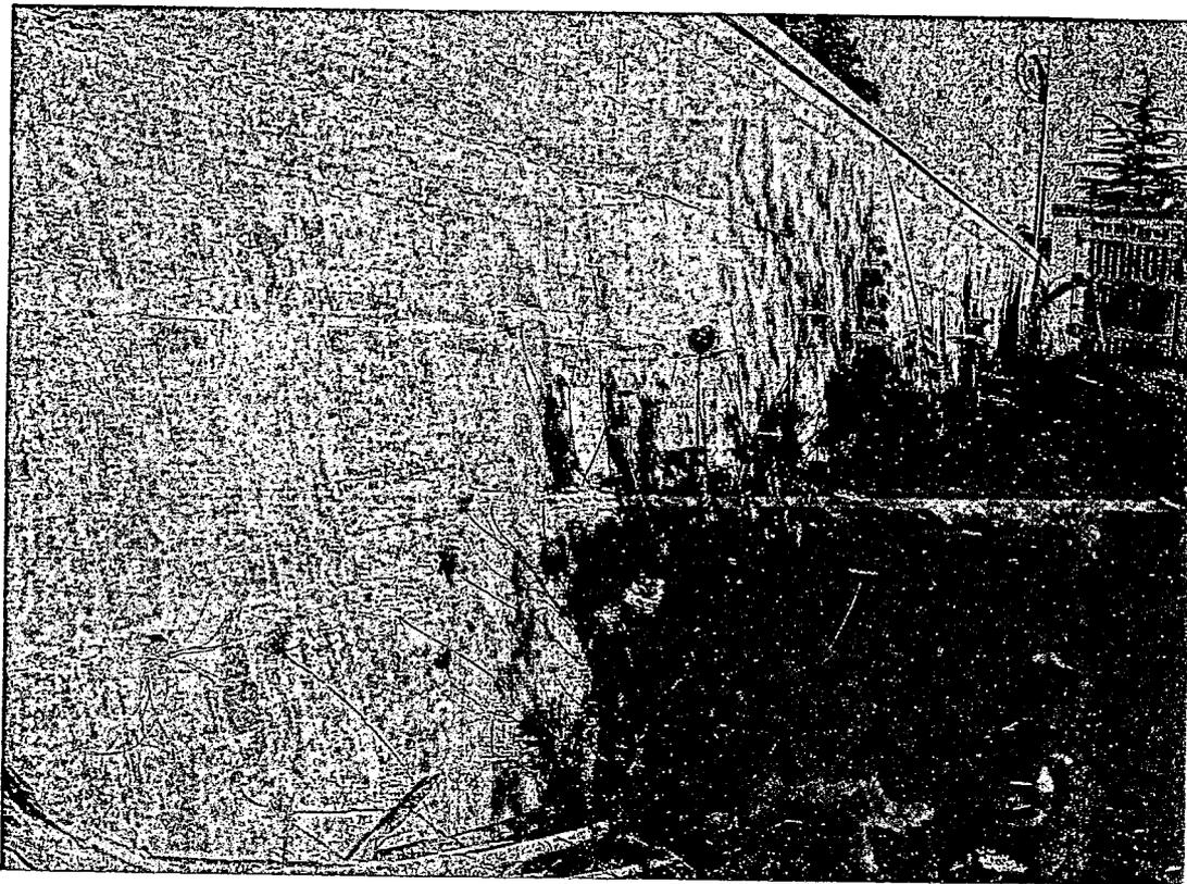
Foto n. 2 SP 52 km2+000 Muro tip. h=2,00m, parapetto in conglomerato cementizio.
